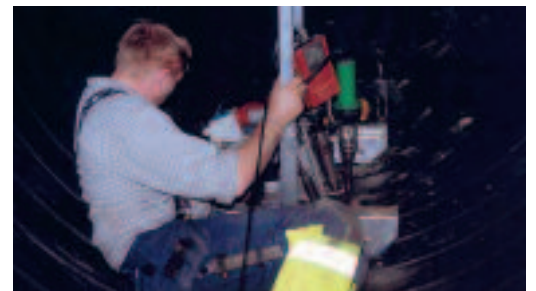
Extrudersvetsning inuti Weholitetrumman på arbetsplatsen.
