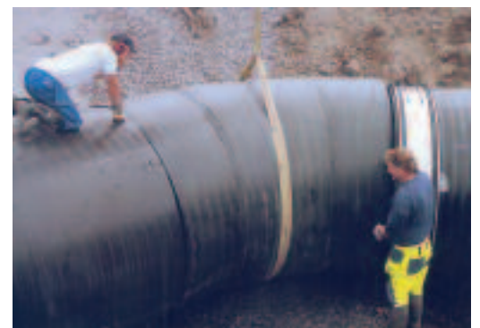
Weholiteböj 42° sammanfogas med Flex-Seal koppling
