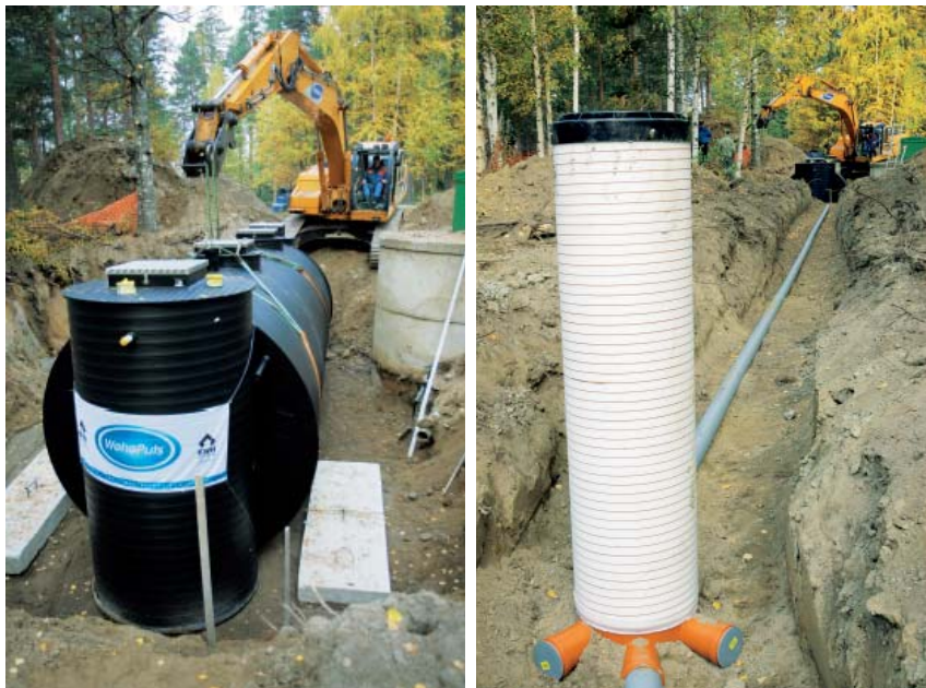
Lite berg fick sprängas bort. I schaktet gjordes en bädd av kross. På grund av närheten till sjön infiltreras utloppsvattnet i marken.
