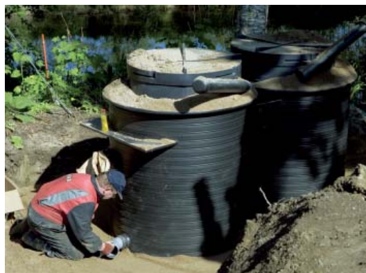
◀ Antti Otavas tomt är belägen intill en å i Karvia. Reningsverkets botten ligger under vattenytan, men något vatten har inte trängt ner i schaktet.
