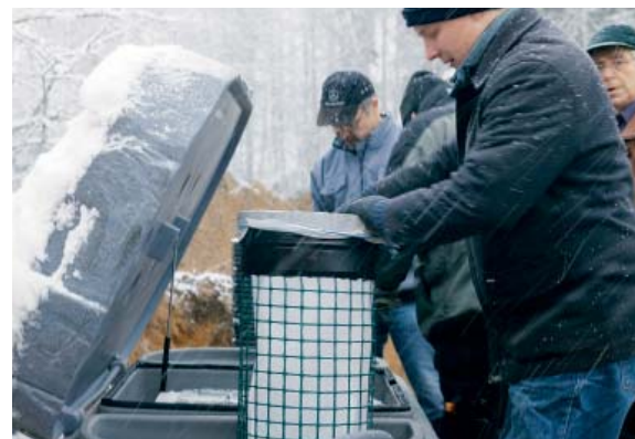
Överskottsslammet överförs från reningsverket till en slampåse.
