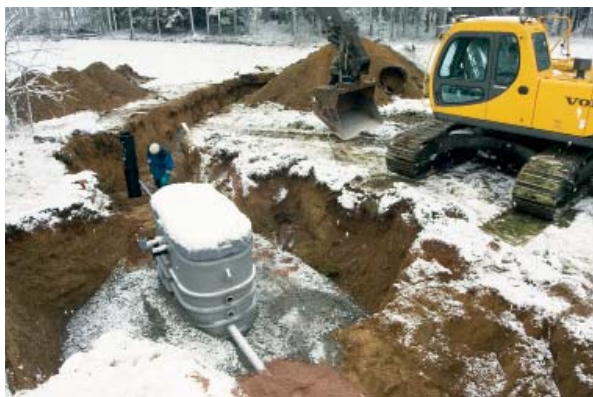
Reningsverket vilar på ett hårt packat justeringslager av sand, grus och kross. Schaktbotten måste vara jämn och plan.
