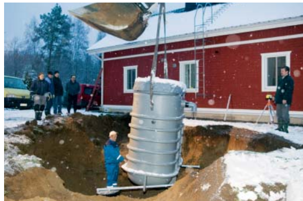
Anläggningen lyftes på plats med hjälp av en skopplastare i vågrät position.
